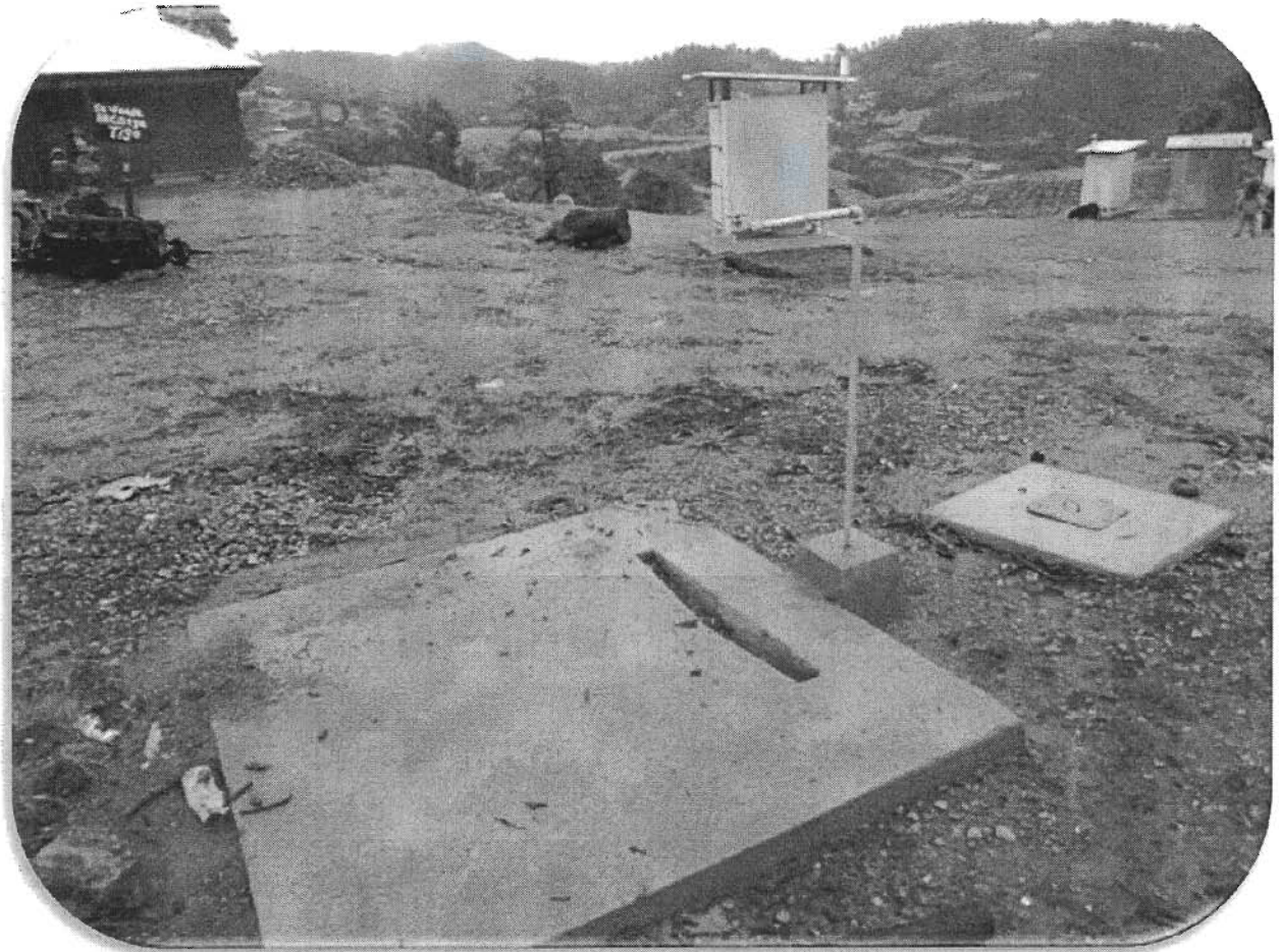
Imagen de la conexión domiciliar, sumidero y letrina, en la comunidad de San José Ixcaniche
