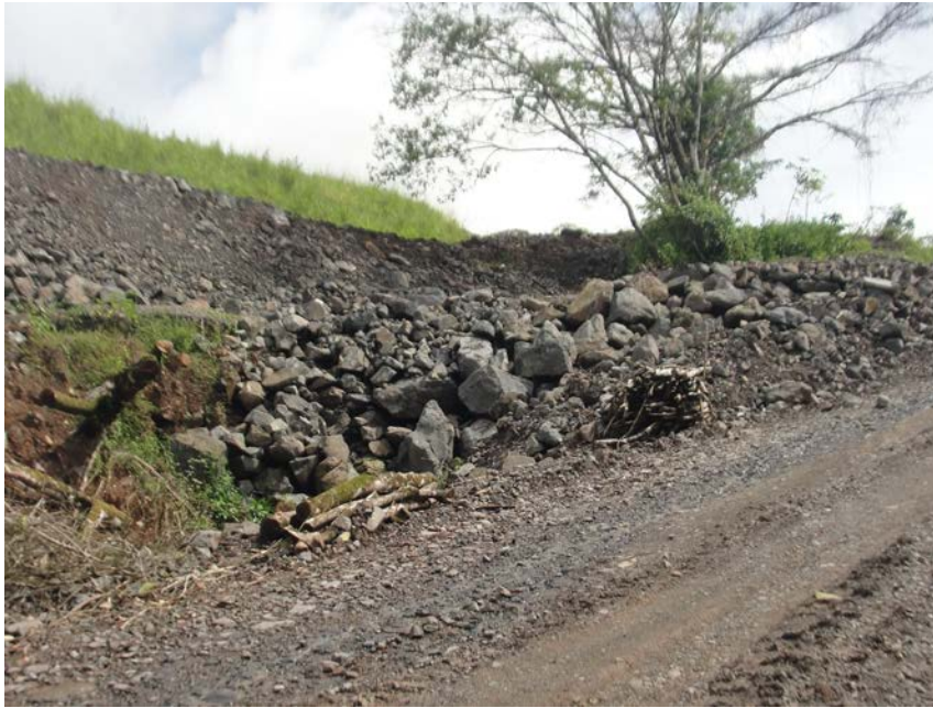
Fotografía 8. Derrumbe de suelo y retén de piedras por la aseveración de los procesos de sedimentación hídrica, debido al despale provocado por la explotación minera de la empresa DESMINIC/B2GOLD. Fuente: Centro Humboldt, Noviembre 2014.
